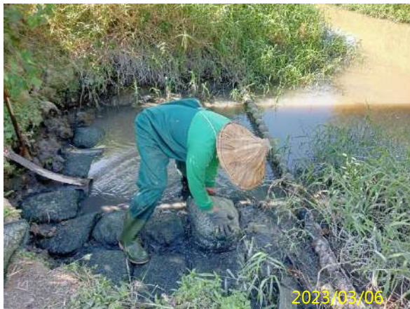
挖除部分汙泥後整齊堆疊碎石包
