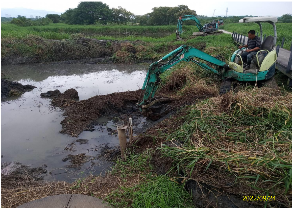
圖 4-21 土堤滲漏維護、修復及連通管、清淤工作照片
